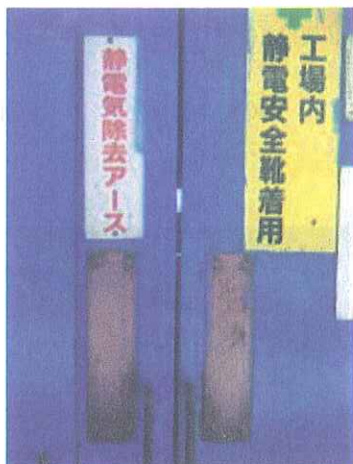
写真8 塗装工場の扉の除電板
