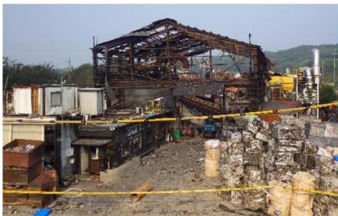
写真1 アルミニウム工場の火災事故の状況
