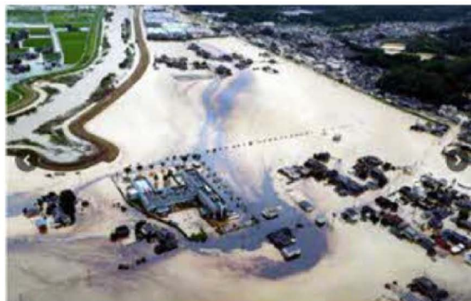
写真2 鉄工所の油流出事故の状況
