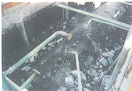
写真2 漏えい事故を起こした専用タンクの地盤面を掘削し、砂等を取り除いた状況
