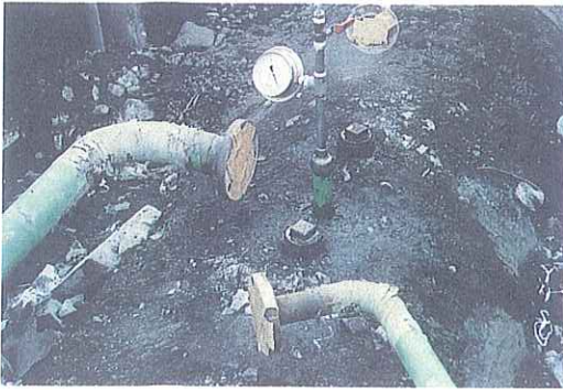
写真3 漏えい事故を起こした専用タンクに圧力ゲージを取り付け、タンク本体に加圧試験を実施している状況
