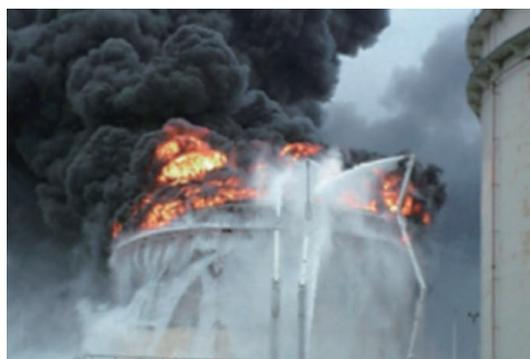
図5 十勝沖地震における浮き屋根タンク全面火災の状況
