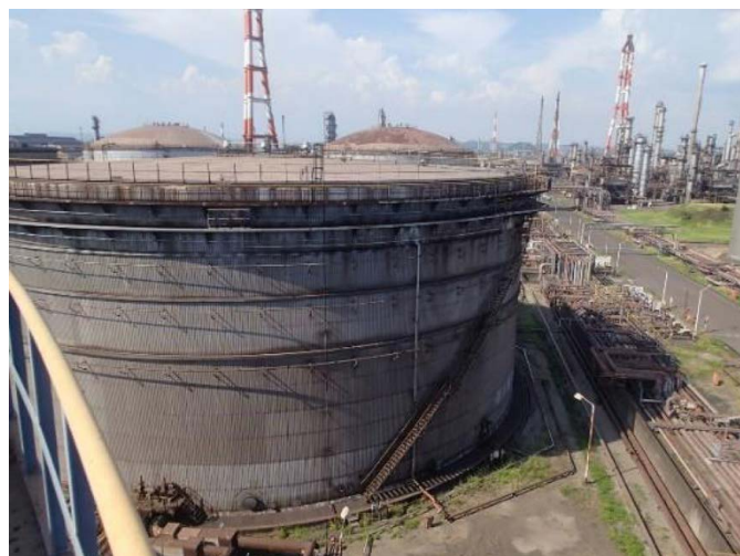
現在の280番タンク(事故当時は270番タンク)を望む
