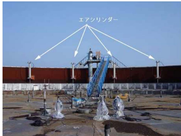
図5 実規模タンクでの浮き屋根揺動実験
