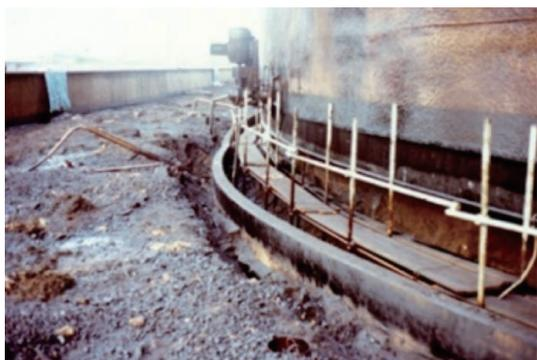
図2 宮城県沖地震で被害を受けたタンク
