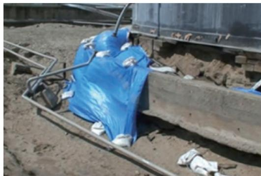
図7 津波による基礎の洗掘
