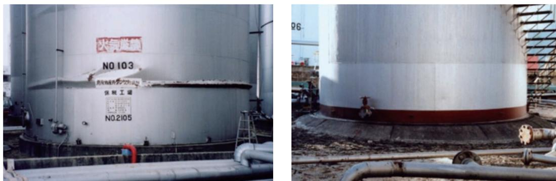
図4 兵庫県南部地震のタンクの被害状況
