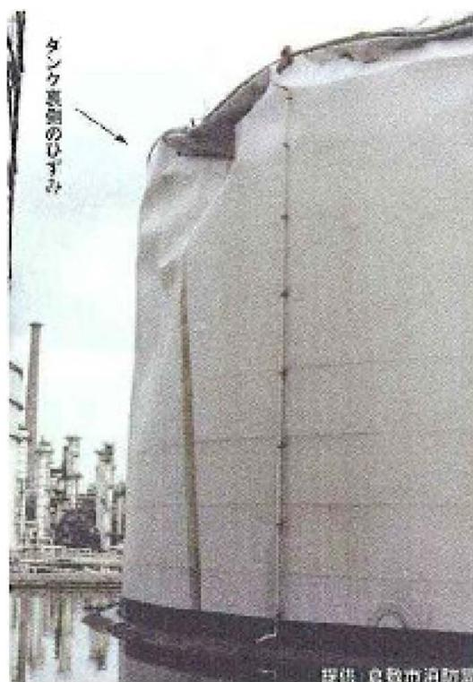
図5 底板破口部の反対側における側板の損傷状況(倉敷市消防局提供)
