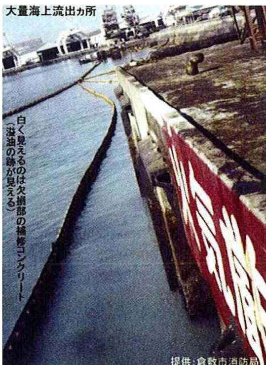
図9 港湾に大量に重油が漏えいした9号栈橋(岸壁の車止め破損箇所(補修されて白色の部分)などから流出した。倉敷市消防局提供。)
