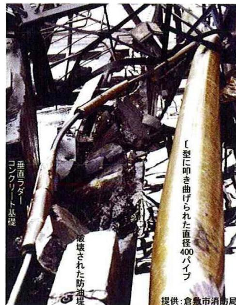
図8 独立階段の衝突による防油堤及び配管の損傷状況（倉敷市消防局提供）
