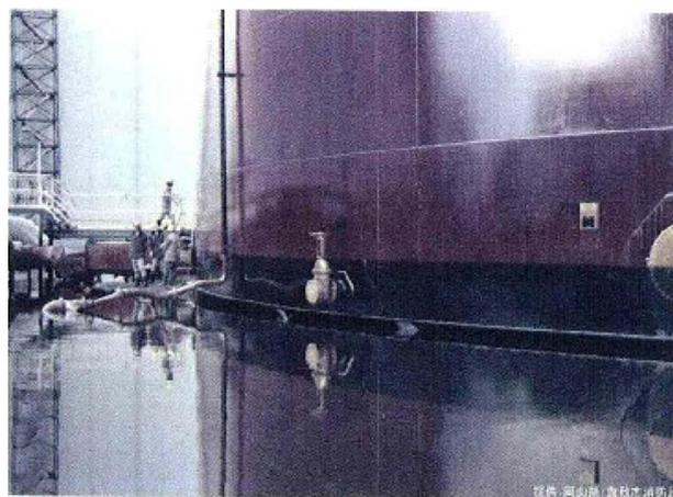
図3 T-270タンク底板の破断箇所付近の滞油の状況(倉敷市消防局提供)
