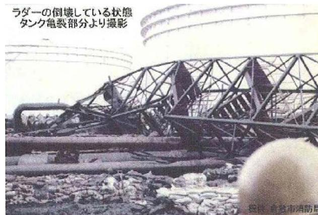
図7 タンク底板破断部から見た独立階段の転倒状況（倉敷市消防局提供）
