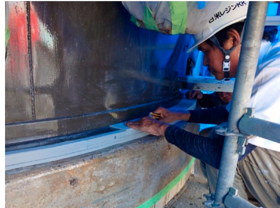
図.9 隅角部へのスペーサーの設置
