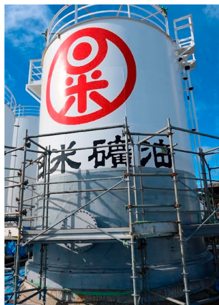
図.15 CFRP貼付け部に仕上げ 塗装（灰色部：下塗り）
