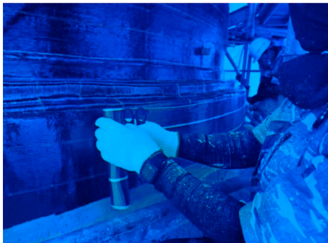
図.14 2層目CFRPの貼付け（周方向に貼付）
