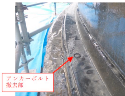
図.7 既存アンカーボルトの撤去
