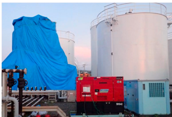
図.6 タンクの養生とエアコン設置
