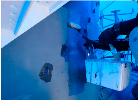
図.8 ケレン後にプライマーを塗布
