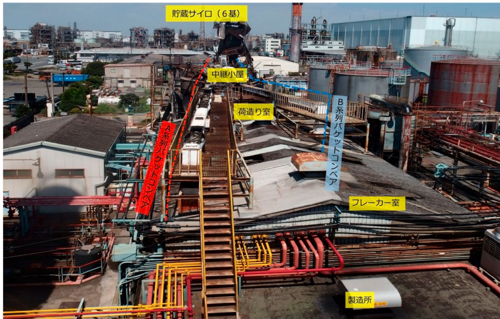
写真4. 関連製造所から製品サイロ方向を撮影
