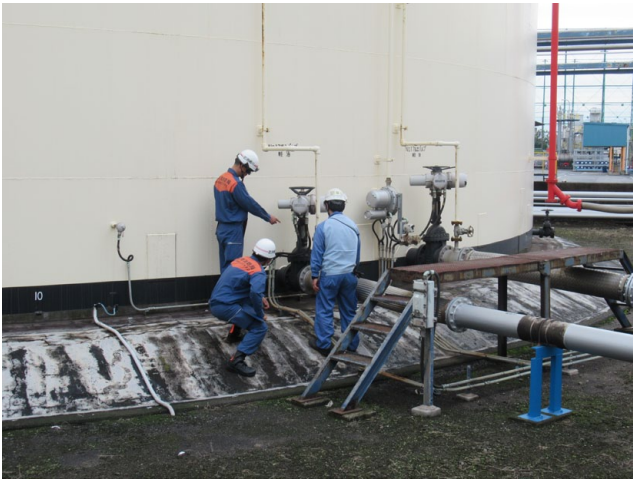
屋外タンク貯蔵所の検査
