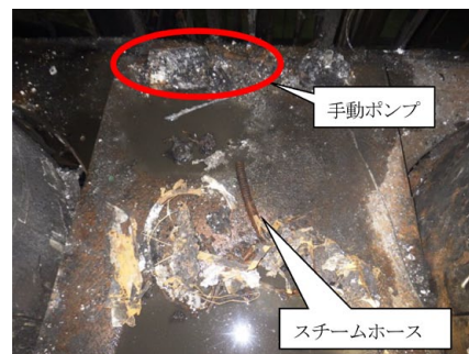
写真8 手動ポンプ及びその他資機材
