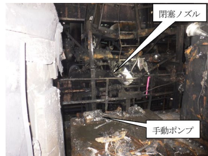
写真6 貫通作業実施場所
