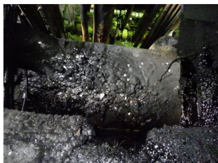
写真9 3階の閉塞ノズル部分から直下の1階部分を撮影
