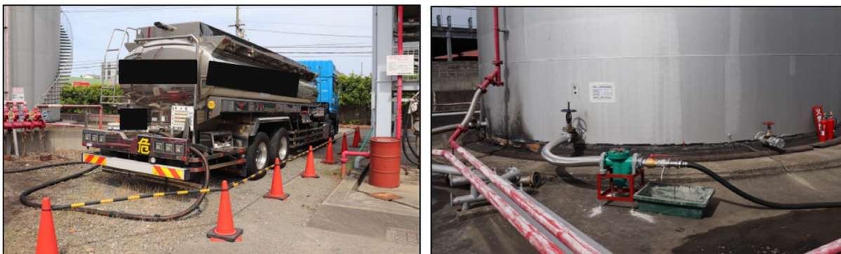
写真11 残油の抜き取りの状況（仮取扱承認）
