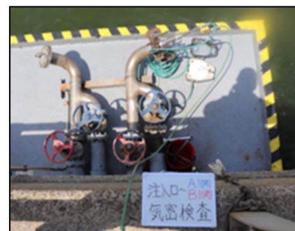
写真10 気密検査状況
