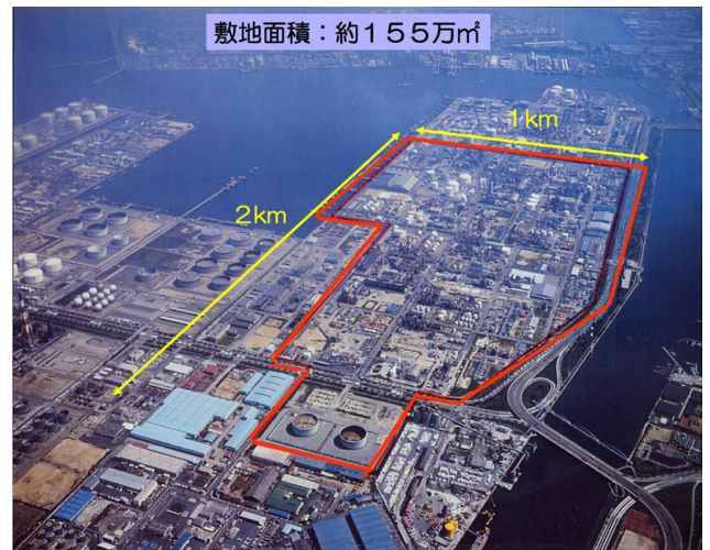
大阪工場全景
