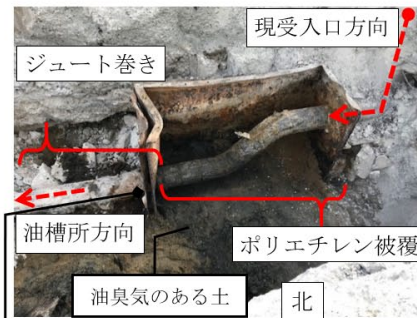
写真6 配管被覆の状況
