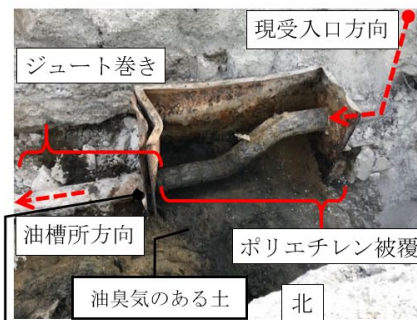
写真6 配管被覆の状況
