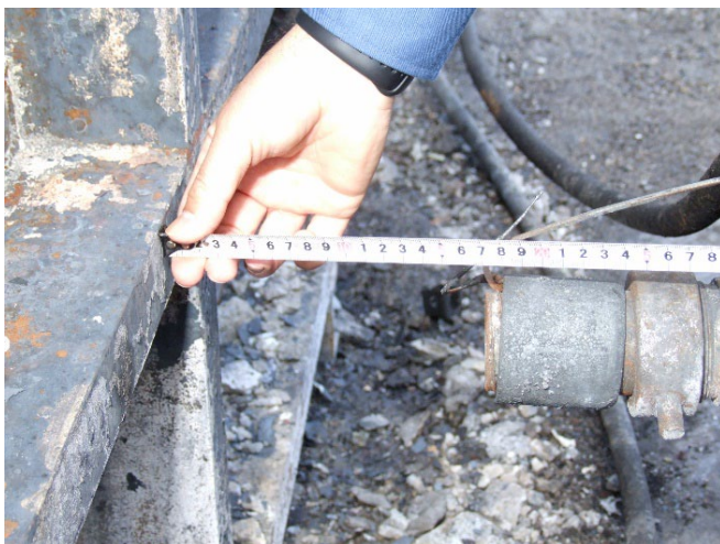
写真15 結合部の間隔の測定
