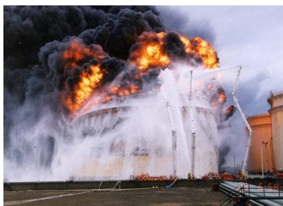
写真2 浮き屋根式屋外貯蔵タンクの全面火災と消火活動の状況（その2）
