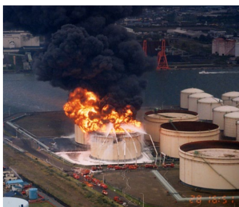
写真1 浮き屋根式屋外貯蔵タンクの全面火災と消火活動の状況（その1）
