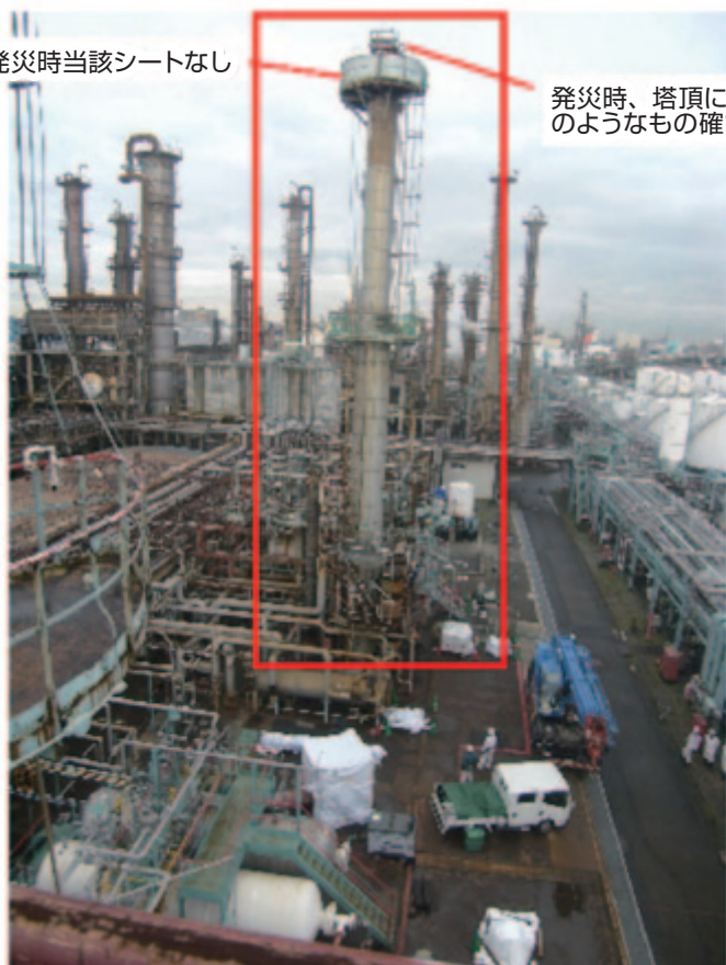
ストリッパー塔外観 (開孔したノズルは塔頂近くのステージ付近)
