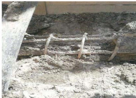
写真 3 支柱の下部の状況
