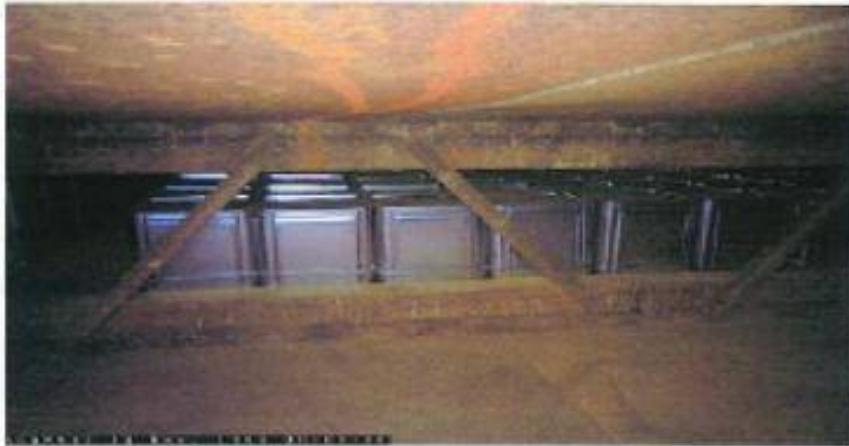
ポンツーンNO, 16インナーリム設置(144缶)
