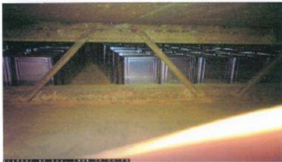
インナーリム側設置 縦置き因縛状態
