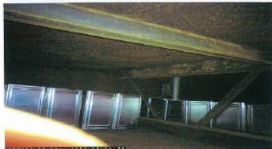
中間部屋及びアウターリム側設置中(縦置き)
