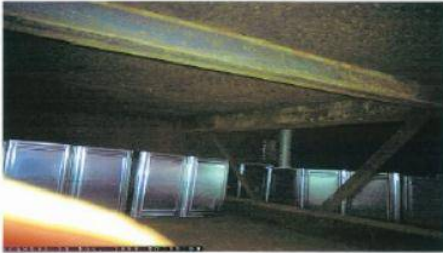
アウターリム棚、中間設置中
