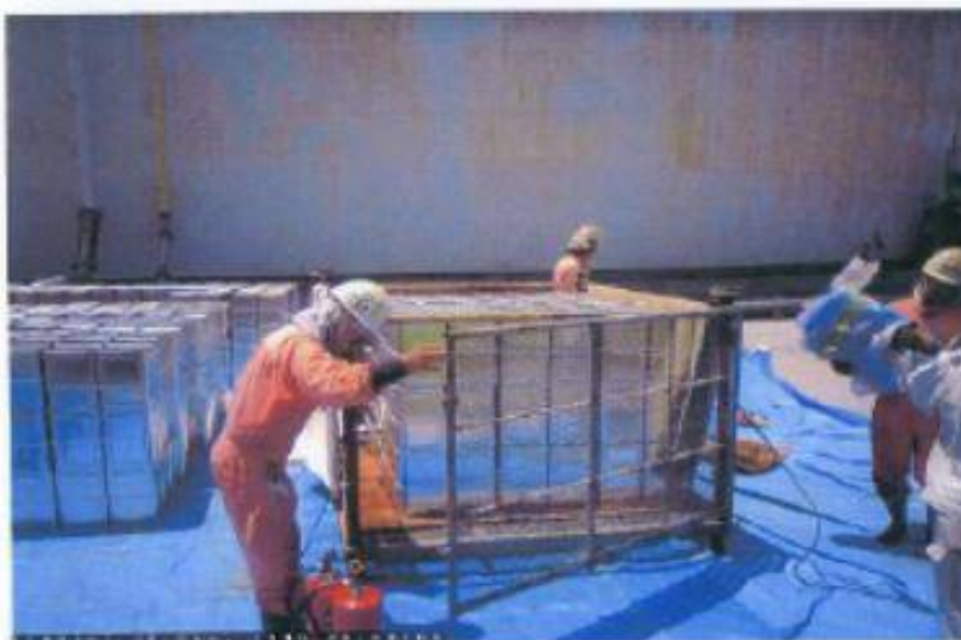
鋼製缶ポンツーン上へ荷揚げ
