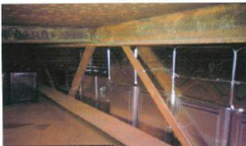
アウターリム側201缶設置完了 合計393缶
