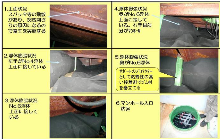
図 設置における状況
