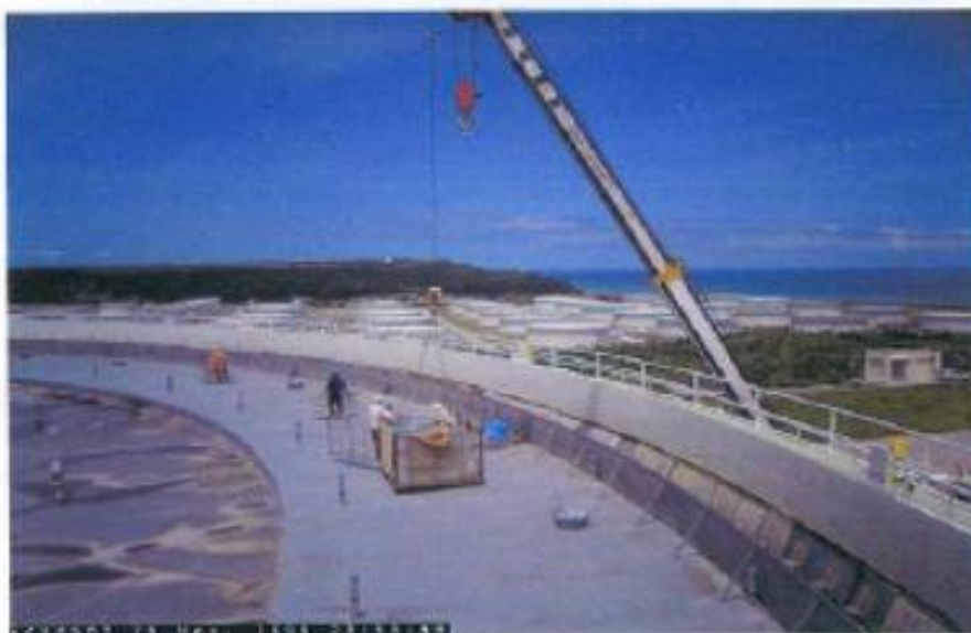
6月6日 Aタンク 屋根上搬入
