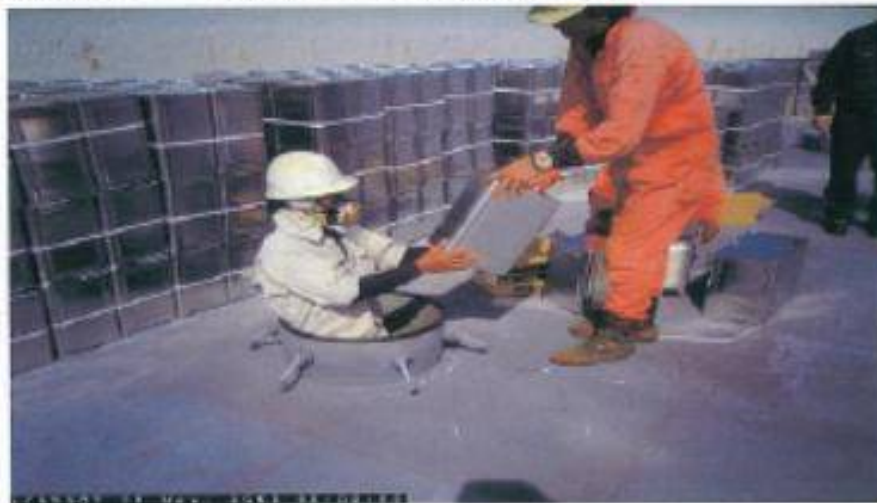
缶ボンツーン内入れ込み中
