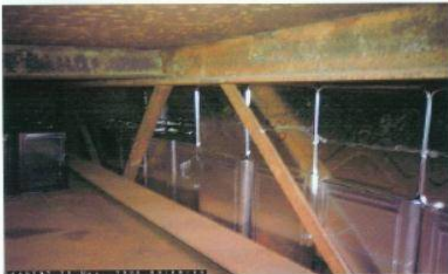
アウターリム側設置状態(1段目縦置き+2段目横置き)設置数量392缶
