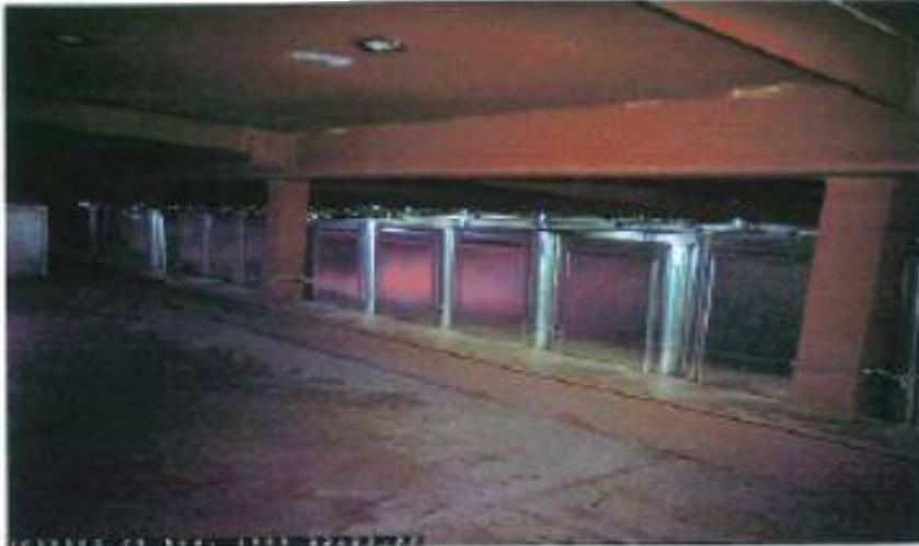
インナーリム設置140箇所
