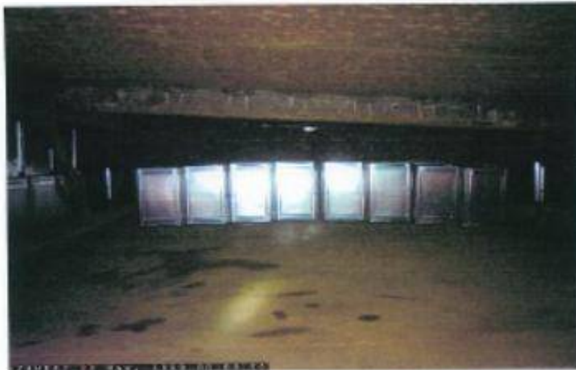
中間部屋 設置
