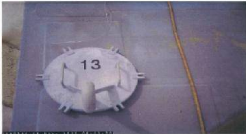
Aタンク ボンツーン NO, 13 鋼製缶設置
