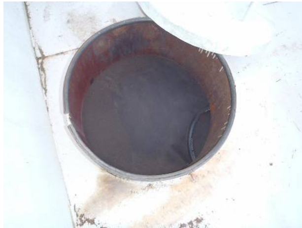
図 浮体設置後の状況（ポンツーンマンホール）
