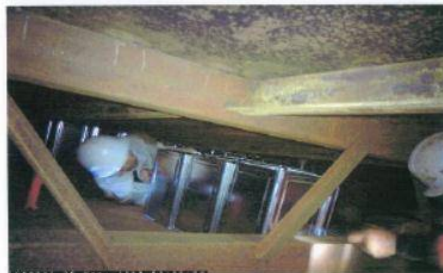
ボンツーンインナーリム設置中
