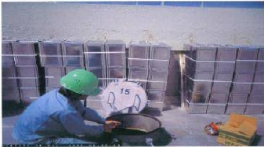
缶設置ボンツーンNO, 15 入槽前環境チェック
