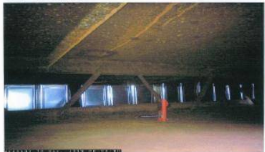
インナーリム側144缶設置完了
