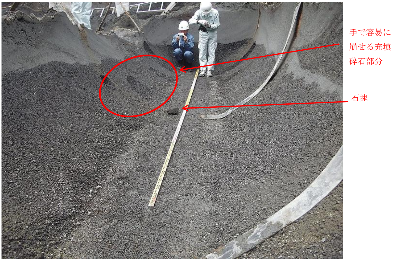
写真2. 1. 1 タンク撤去後の碎石基礎の状況 (KHK659)
